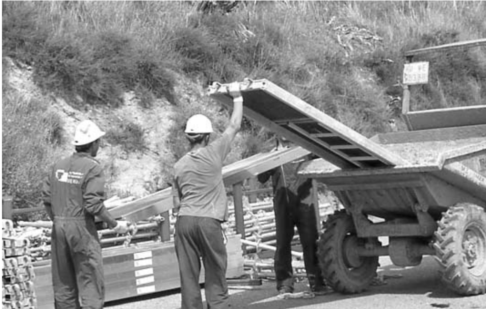
Este personal comprobará las condiciones de seguridad en las empresas y desarrollará funciones en materia de prevención
